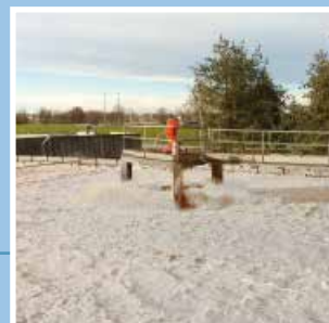
Installazione di aeratore di superficie tipo ASP-F. Installation of a surface aerator type ASP-F.
