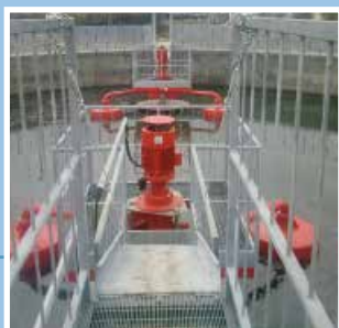
Installazione di aeratore di superficie tipo ASP-G. Installation of a surface aerator type ASP-G.
