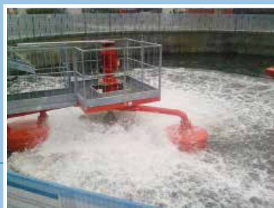
Installazione di aeratore di superficie tipo ASP-G. Installation of a surface aerator type ASP-G.
