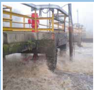
Installazione di aeratore di superficie tipo ASP-F. Installation of a surface aerator type ASP-F.
