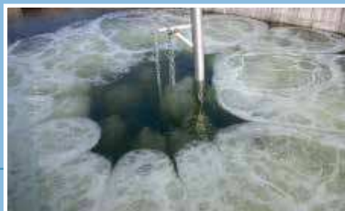
Fasi di avviamento di aeratore sommerso radiale. Starting stages of a radial submersible aerator.
