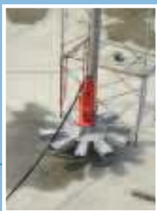
Installazione di aeratore sommerso tipo SCLK. Installation of a submersible aerator type SCLK.
