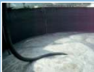
Aeratore sommerso tipo SCLK in funzione in vasca di ossidazione. Submersible aerator type SCLK working inside an oxidation tank.
