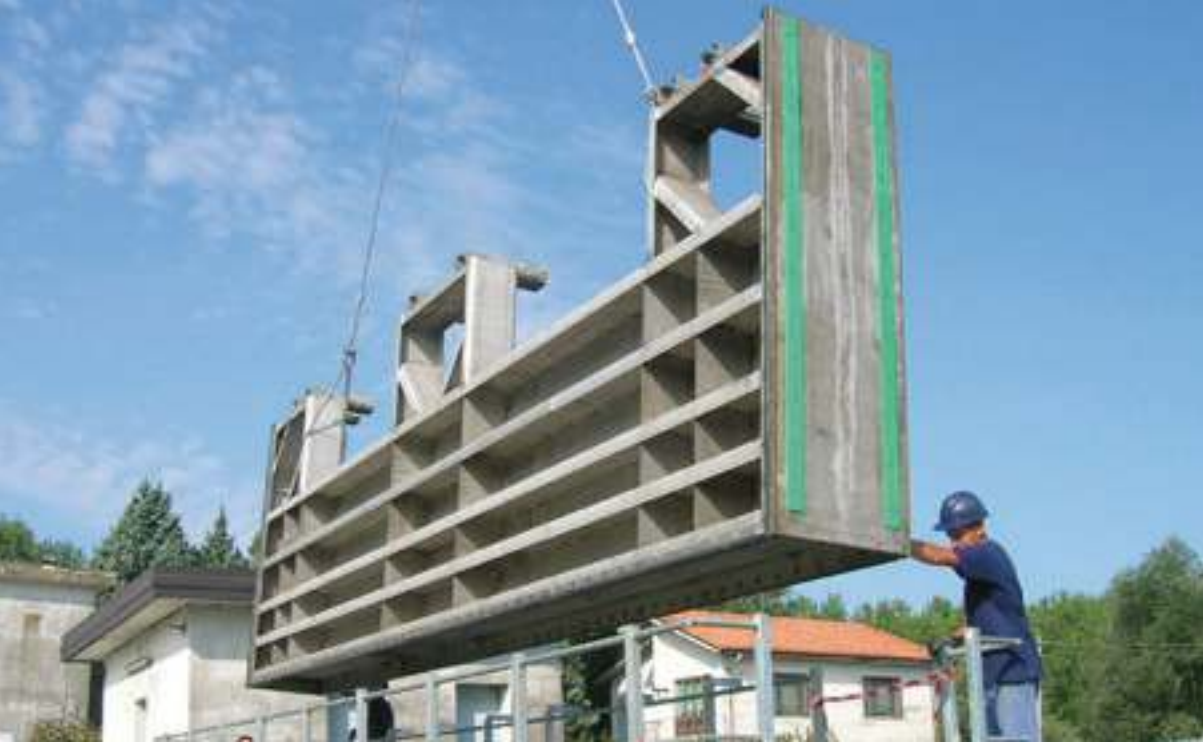
Paratoia in acciaio inox con doppio otturatore scorrevole
