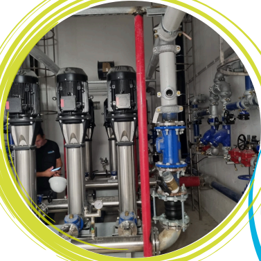
מערכת HYDROMAT עם משנה תדר לכל משאבה בקר וצג מגע מתוצרת סימנס
