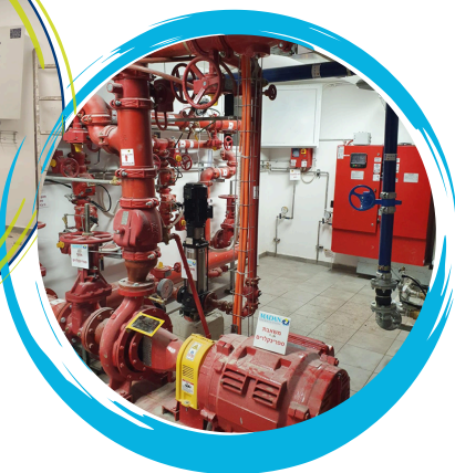
מערכת HYDROMAT עם משנה תדר לכל משאבה בקר וצג מגע מתוצרת סימנס
