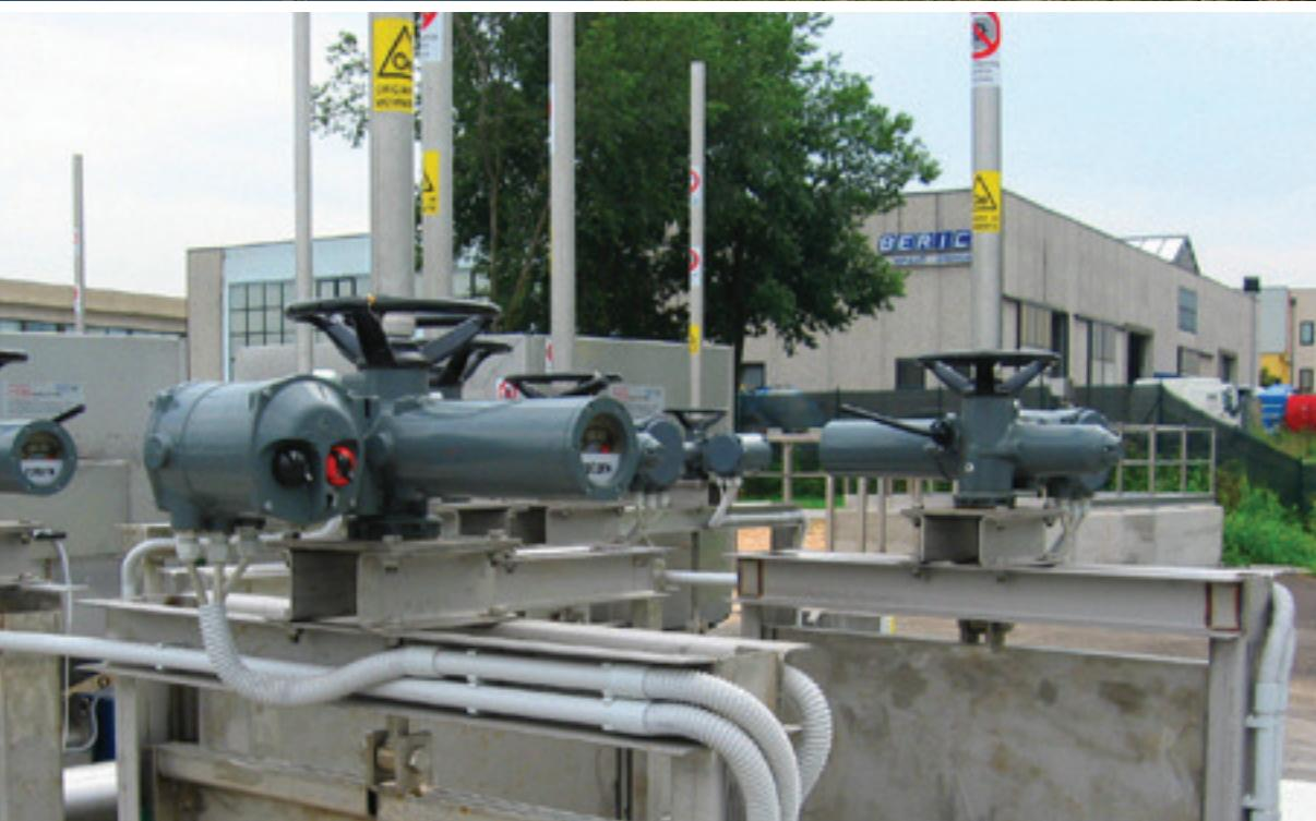
Paratoie a tenuta su tre lati motorizzate per impianto di depurazione
