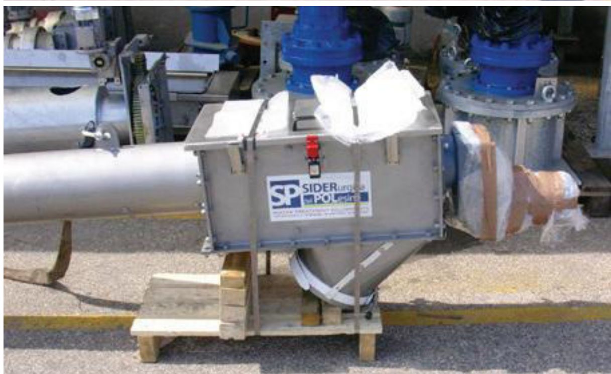
05-0362 Zona compattazione. Compaction area.
